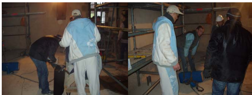
Montage de la potence et du nouveau treuil
