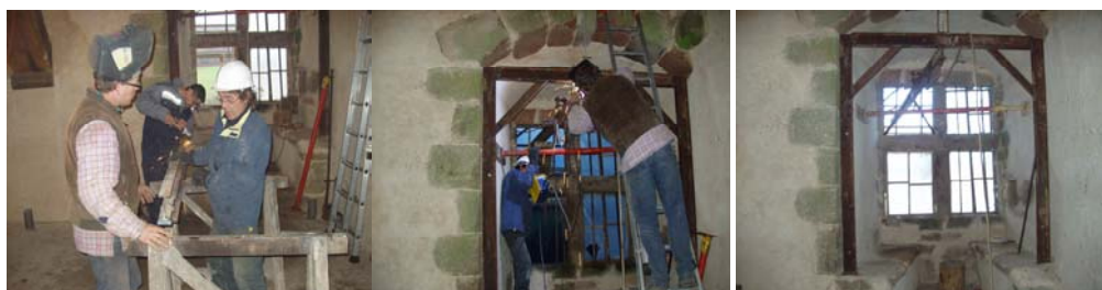
Montage des solives
