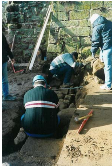
Consolidation des fondations
