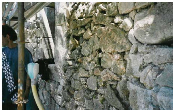
Restauration de la poche
