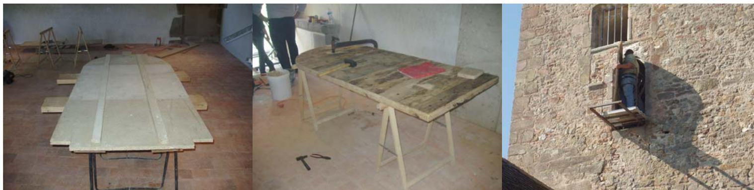
Les portes ont été clouées à chaud avec des clous forgés pyramidaux de type marinier. Cette opération mobilise deux personnes un cloueur au-dessus de la porte et un autre en dessous qui recourbe les clous chauffés et les enfonce définitivement. Après cela, Gauthier pose les pentures et les serrures à bosses. Une fois la porte posée sur ses gonds, nous l'avons traitée à l'huile de lin.
