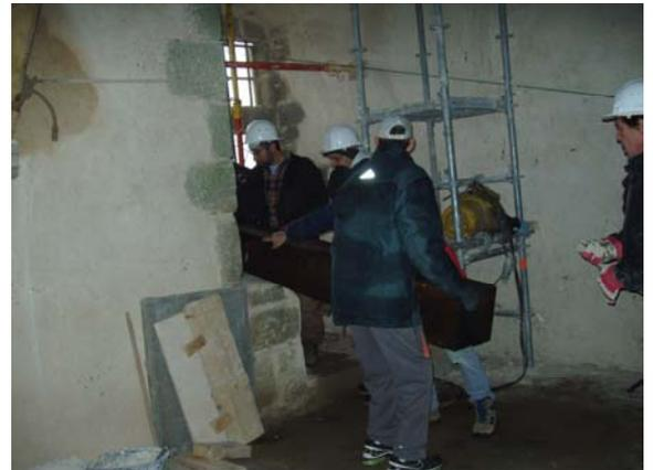
*Taille des encoches, pose des solives et bouchage des trous à la chaux*
