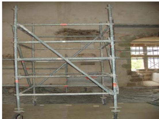
*Montage d'un échafaudage côté est pour réceptionner la poutre*
