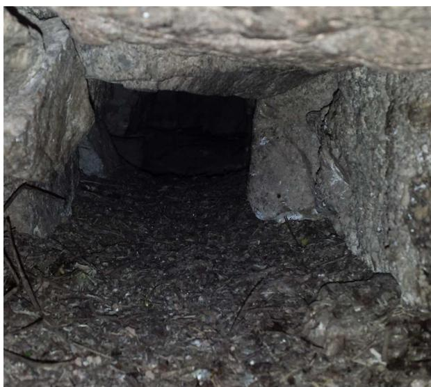
Lors de ce travail, nous avons découvert un trou caché par une simple pierre. Il est en forme de carré d'environ 15 cm de côté et long de 2m10. Il traverse le mur au niveau du 4ème étage et est bouché à son extrémité. Nous ne savons absolument pas à quoi il peut correspondre, des photos ainsi qu'une vidéo sont prises en attendant d'avoir une explication sur son utilité à l'époque.
