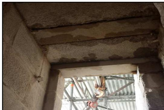
Nous terminons les jointoiements du parapet intérieur côté chemin de ronde. Une fine chape est réalisée au-dessus du vestibule. Il nous faut disposer des planches de coffrage tout autour en s'alignant avec la hauteur finie du parapet. Des finitions diverses comme des retouches d'enduit, du layage et du piquetage sur certaines pierres, les arases des murs, l'embellissement des pigeonniers, sont également au programme.
